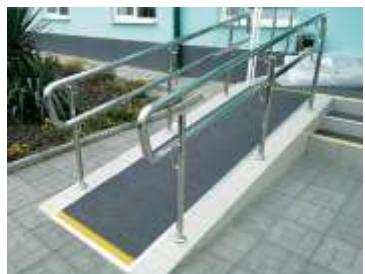
Телескопический пандус-предназначен для установки на маршах лестниц, где строительство стационарного пандуса помешает проходу пешеходов. Изготавливается из прочных материалов, способных переносить большие
