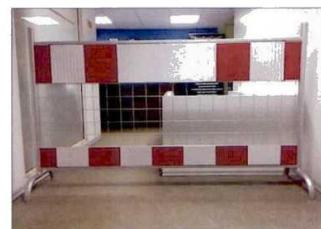
При производстве аварийных работ ограждение зоны производства работ должно иметь сигнальный бело-красный или красно-желтый цвет.
