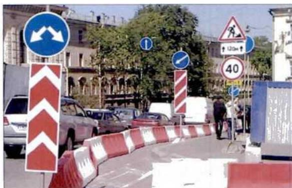
Ограждения выполняются из дорожных блоков (водоотливные ограждения) и предназначены для временного визуального ограждения территории, на которой проводятся ремонтные или строительные работы. Ограждения из дорожных блоков могут быть дополнительно оборудованы световозвращателями и сигнальными фонарями.
