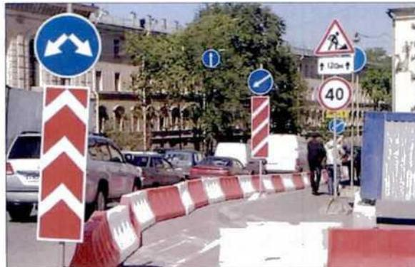
Ограждения выполняются из дорожных блоков (водоналивные ограждения) и предназначены для временного визуального ограждения территории, на которой проводятся ремонтные или строительные работы. Ограждения из дорожных блоков могут быть дополнительно оборудованы световозвращателями и сигнальными фонарями.
