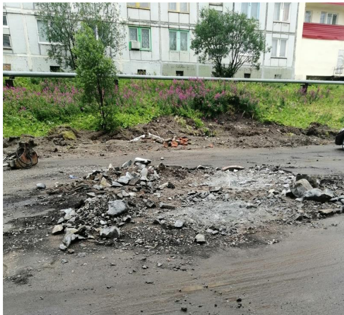
Демонтаж камня-газон около дома № 23 на ул. Заречная
