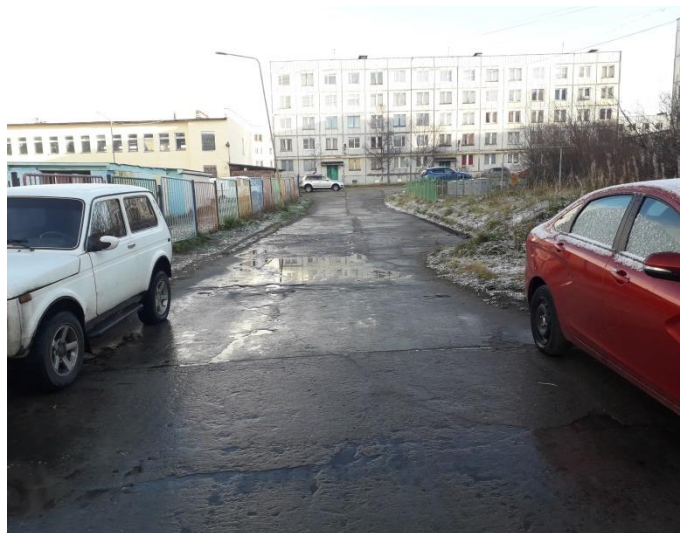
Дорога к дому №13 ул. Заречная
